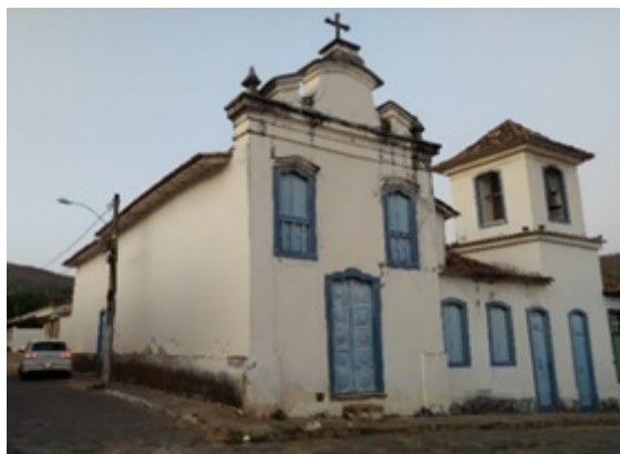
FIGURA 8 Igreja de Nossa Senhora da Abadia, Cidade de Goiás. Fonte: Fernando Santos (2020).
