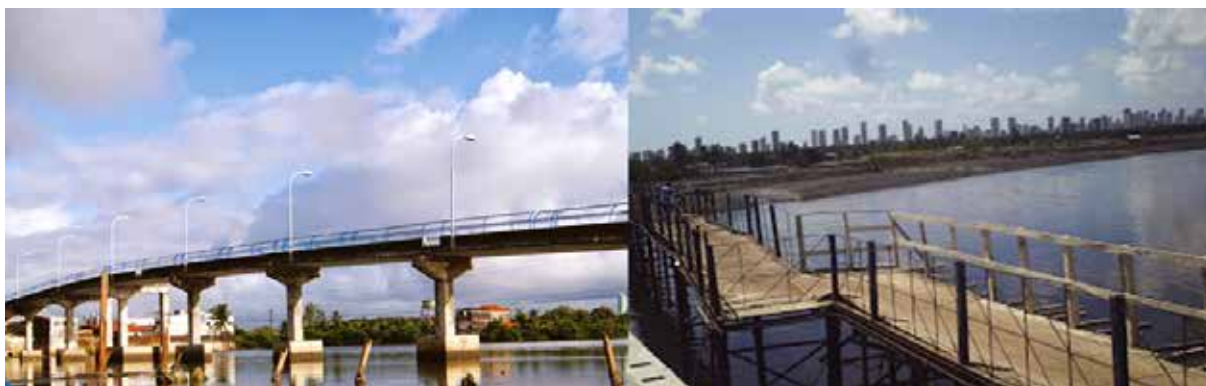
Figura 2 – A ponte de acesso à Ilha de Deus – antes e depois
