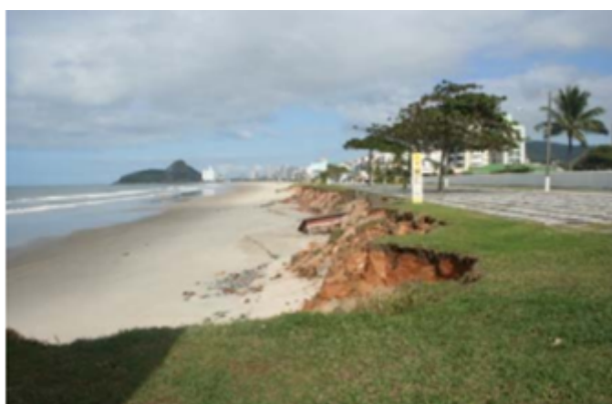
FIGURA 2 Praia Brava em Matinhos, litoral do Paraná. Erosão provocada pela maré irregular e imprevisível. Projeto Orla do município de Matinhos
