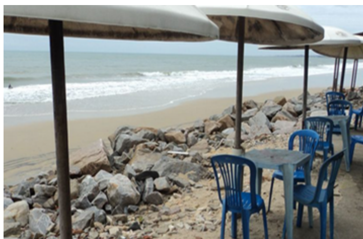
FIGURA 1 Processos erosivos com perda de praia em Icarai (Fortaleza, CE). Fernandes, 2011.
